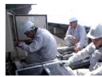
発電所の検査サービス
